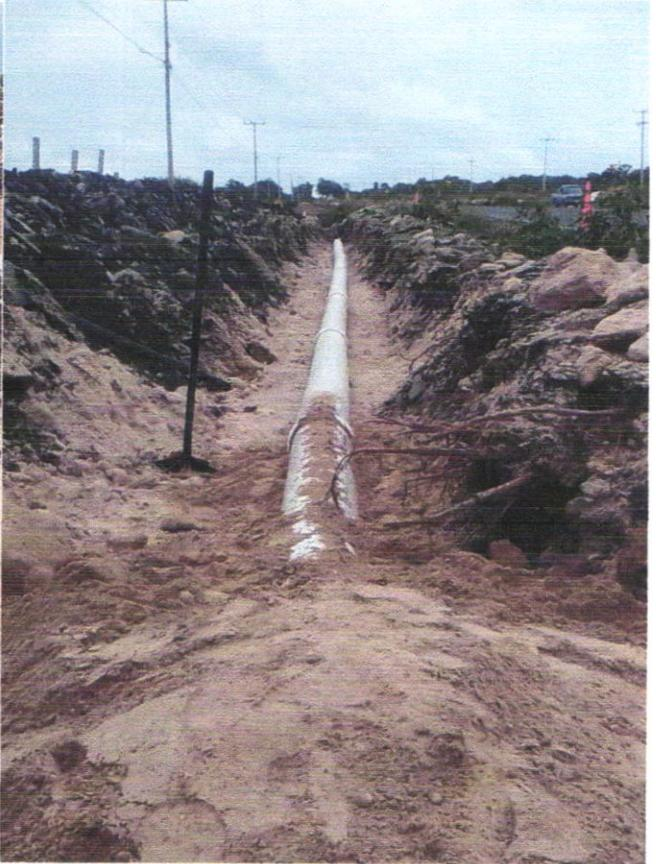
Concluimos con la instalación de la línea pozo Zermeño a tanque elevado #1 satisfactoriamente e iniciamos con pruebas de presión en la línea para descartar cualquier fuga o fallo en la línea dando por hecho que la línea paso la prueba una vez realizada la pruebas.
